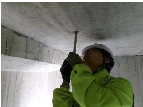
탄산화깊이 측정 현황
