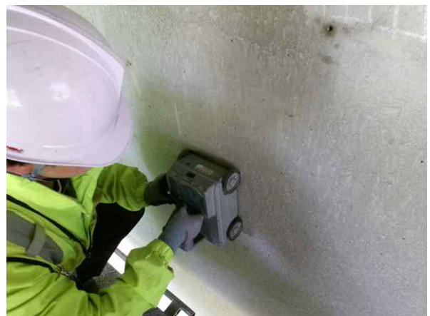
철근탐사 시험 현황
