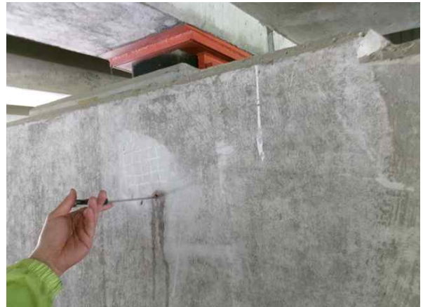
탄산화깊이 측정 현황
