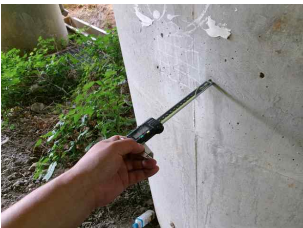
탄산화깊이 측정 현황
